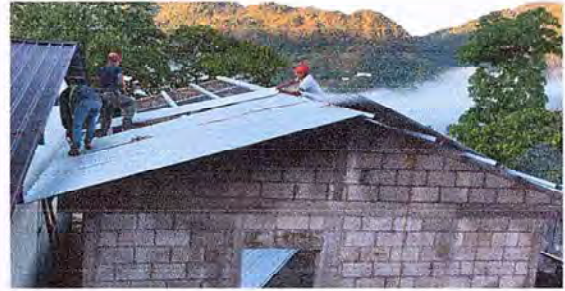
Foto 4: Se observa la colocacion de lamina del modulo 2
