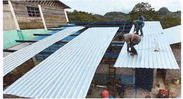
Foto 2: Se observa el cambio del techo modulo 1
