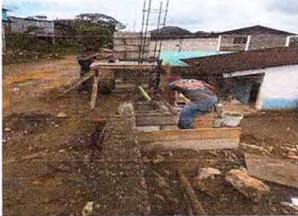
Foto 1: Se observa la construcción del portón
