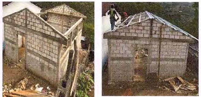
Foto 6: Se observa la colocacion de las costanera del modulo 2
