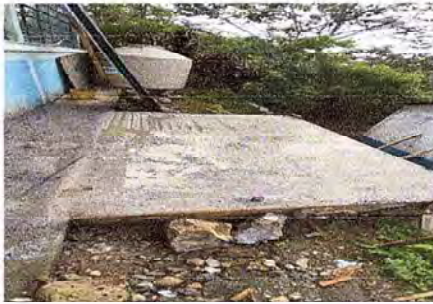
Foto 3: Se observa la culminacion del lugar del deposito de agua
